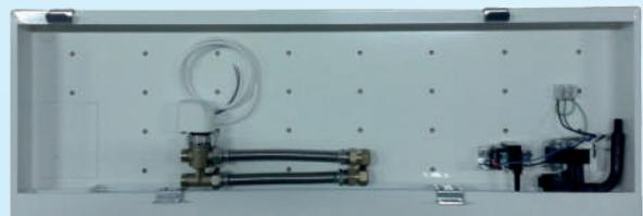
Задняя коробка для подключения с установленными различными дополнительными принадлежностями
