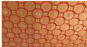
Встановлені високоефективні глиняні модулі, з прокладеними трубками
