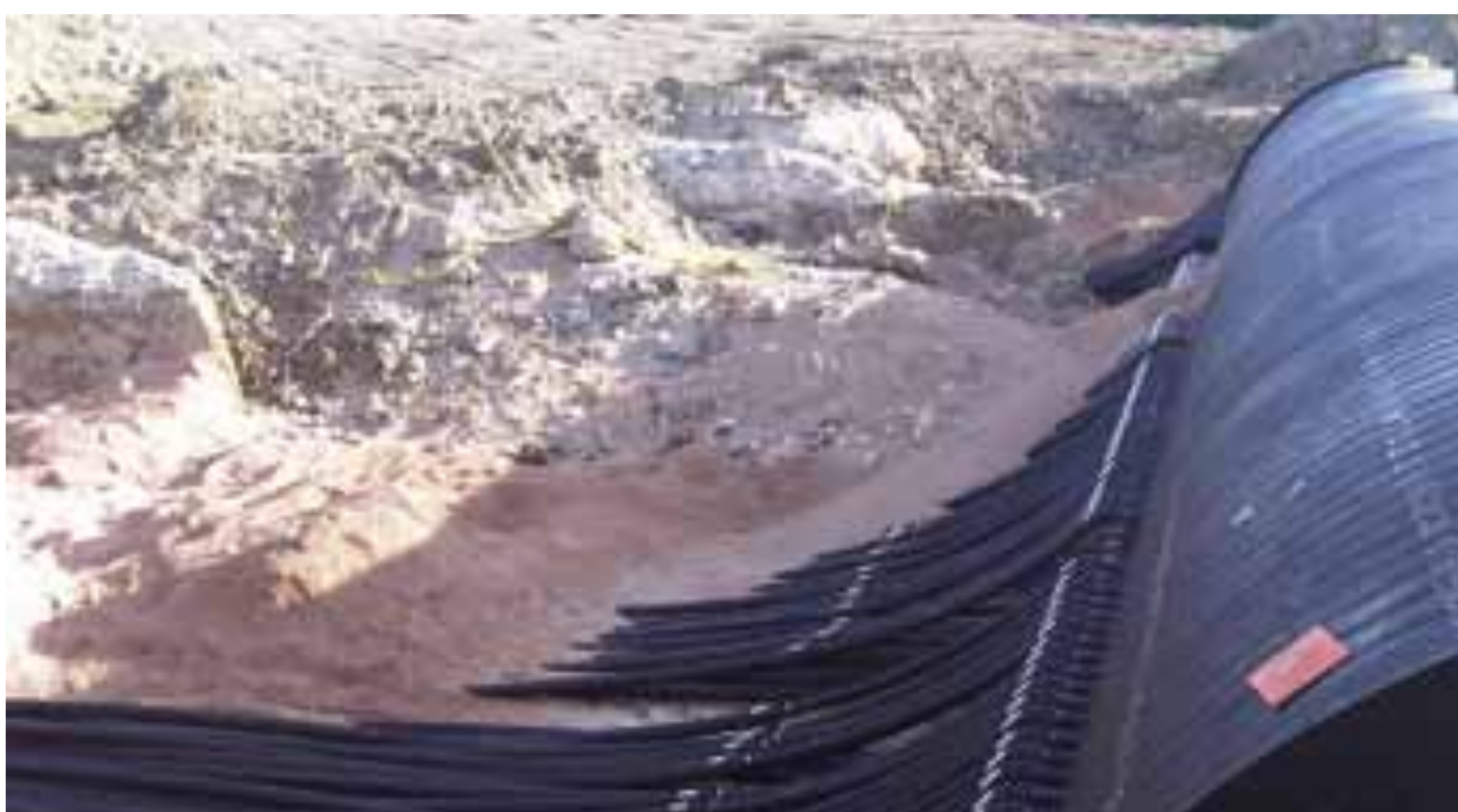
З'єднувальні лінії на розподільнику горизонтальної конструкції
