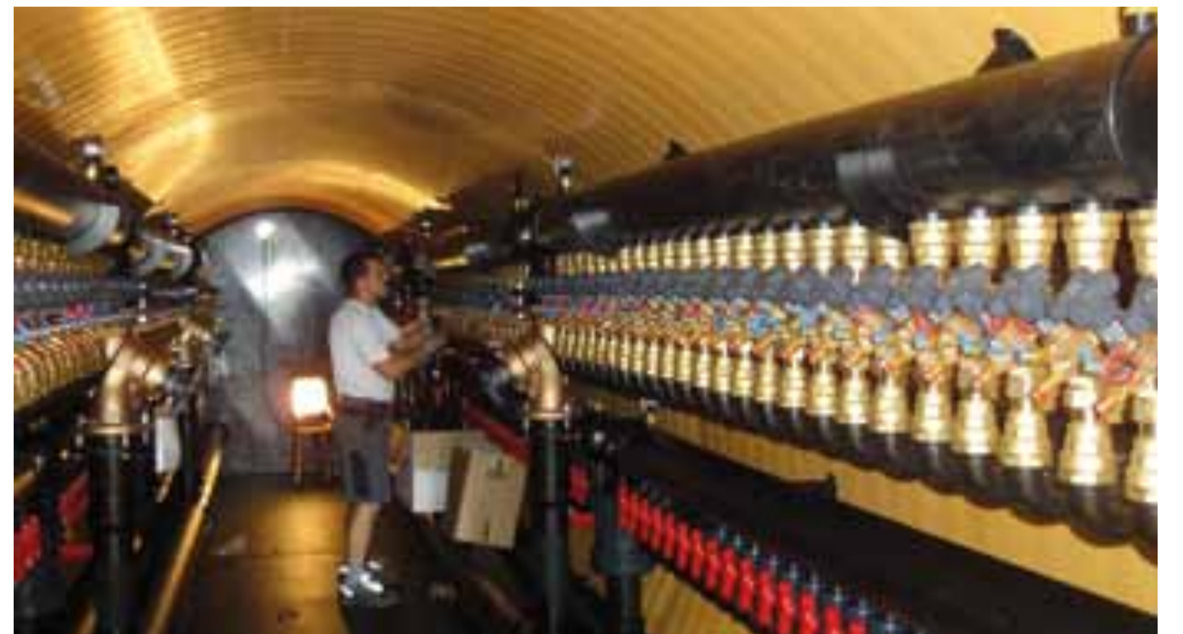
Компонети підключення та регулювання геотермального розподільника
